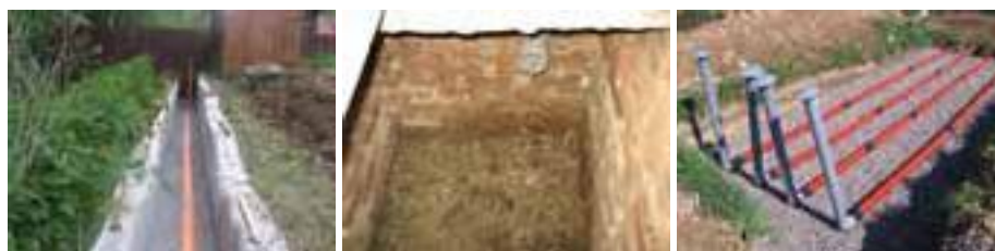
Рис. 1. Фильтрующая траншея, фильтрующий колодец из кирпича, поле подземной фильтрации.
